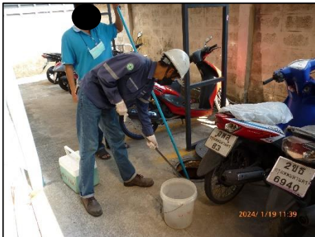
น้ำเสียก่อนเข้าระบบบำบัดน้ำเสีย จุดที่ 3
