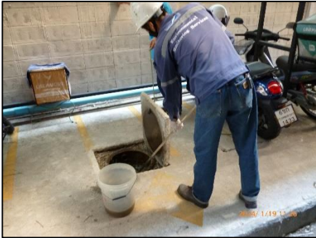
น้ำเสียก่อนเข้าระบบบำบัดน้ำเสีย จุดที่ 2
