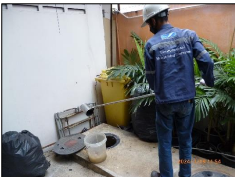
น้ำเสียก่อนเข้าระบบบำบัดน้ำเสีย จุดที่ 4
